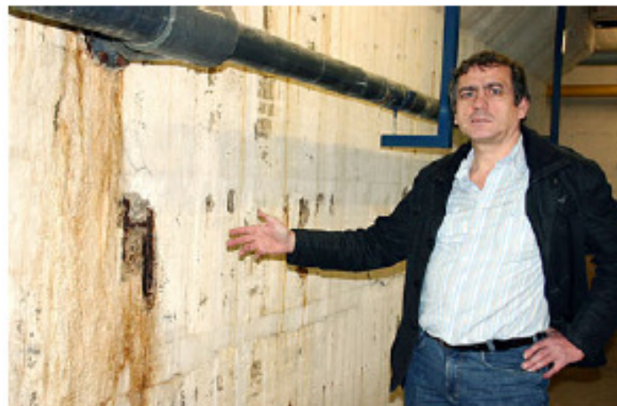
Mehr als nur ein Sanierungsfall: Heinrich Luhr zeigt den frei liegenden Bewehrungsstahl im Keller des Hallenbades. Foto: kei
