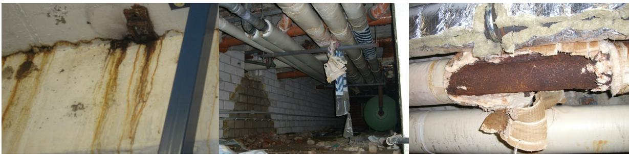
Der Beckenkopfanschluss ist seit Unter der Isolierung sehen sämtliche Rohre (Heizungs-, Vorlauf-, über 10 Jahren undicht. Warmwasservorbereiter) entsprechend aus.
