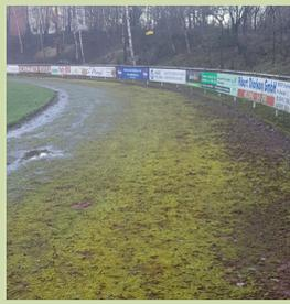
Eine Sanierung der Laufbahn und der Weitsprunganlage in Asche entspricht nicht mehr dem heutigen Standard. Von Lieferfirmen für Laufbahnen wurde uns bestätigt, dass Neuanlagen oder Komplett-sanierungen in den letzten 10 Jahren nicht mehr in Asche ausgeführt worden sind. Eine Sanierung bedeutet praktisch einen Neubau der Laufbahn.
